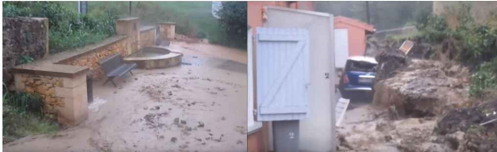
Figure 5 : Coulée de boue à St-Sever (40) en 2015
