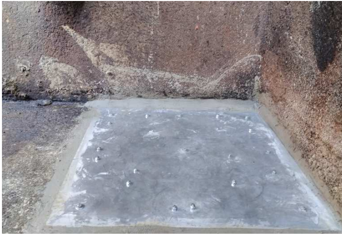
Figure 26 : Radier après réparation
