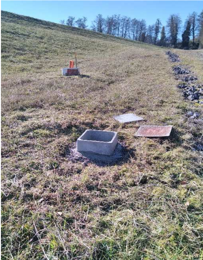
Figure 27 : Pose de buses des regards des drains en janvier
