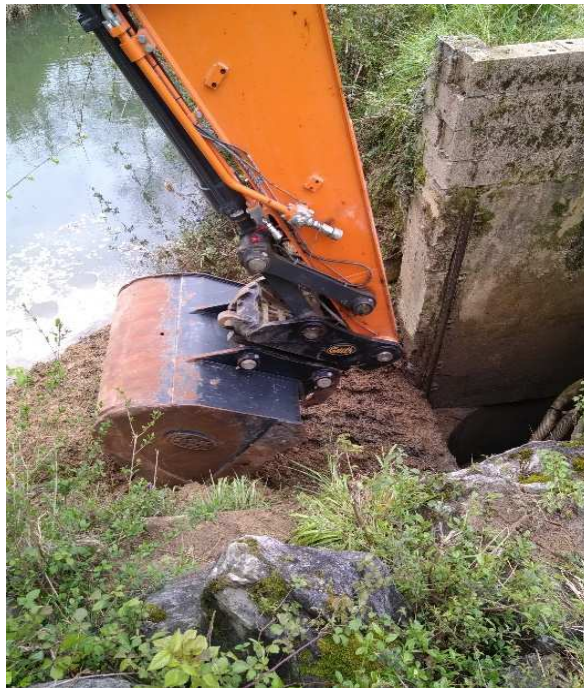
Figure 13 : Nettoyage de la prise d'eau en avril
