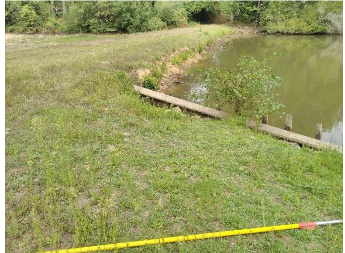
Figure 36 : Marche d'érosion sur les parements de la digue amont du barrage d'Arthez
