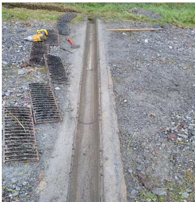
Figure 24 : Nettoyage des caniveaux du lac en décembre
