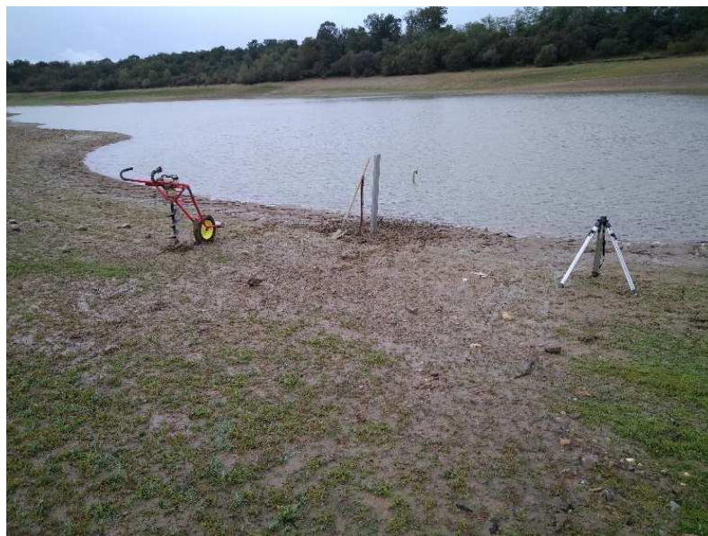
Figure 12 : Opération de maintenance des échelles limnimétriques (remplacement supports + échelles)
