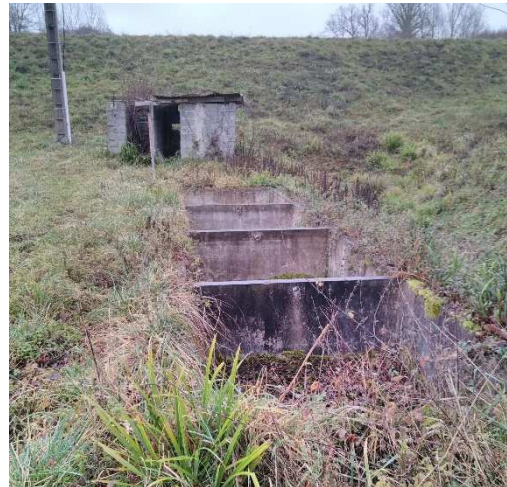
Figure 40 : Vue sur le local technique dégradé et sur les bassins sans protection antichute
