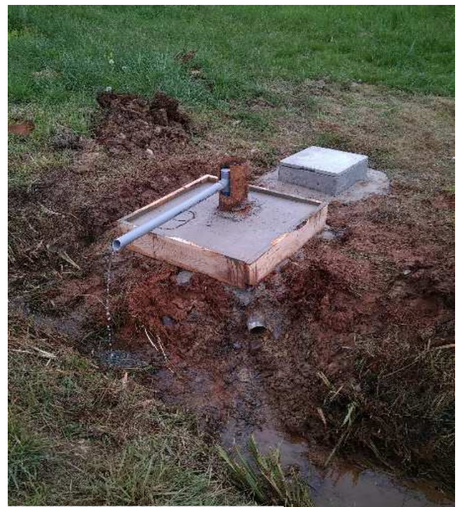
Figure 19 : Piézomètres après réparations
