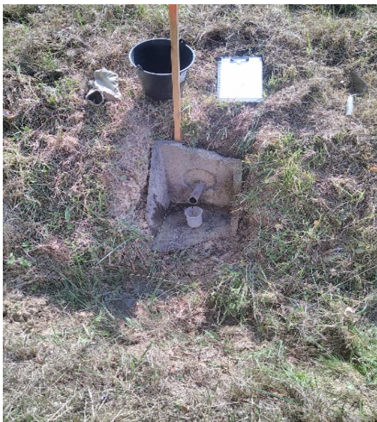
Figure 4 : Réfection d'une sortie de drain
