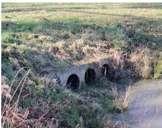
Figure 37 : Buses du barrage de Bougnères
