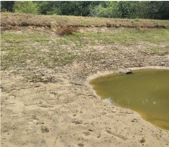
Figure 36 : Marche d'érosion sur les parements de la digue amont du barrage d'Arthez
