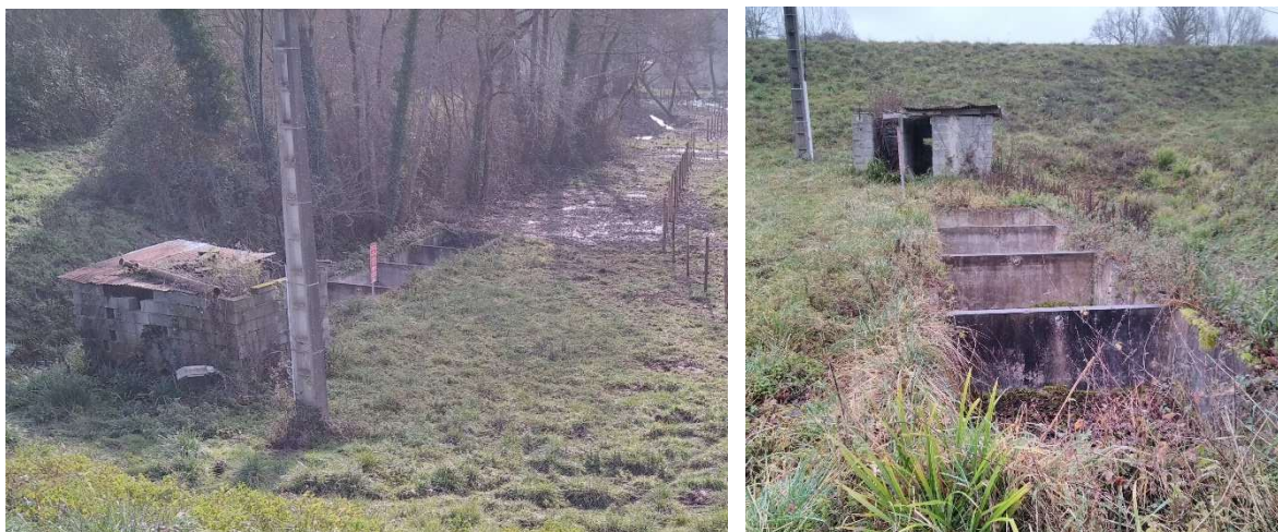
Figure 19 : Vue sur le local technique dégradé et sur les bassins sans protection antichute
