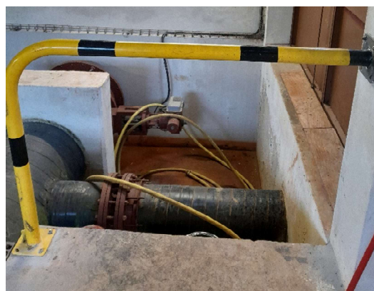
Figure 10 : Garde-fou dans la chambre des vannes du barrage du louet
