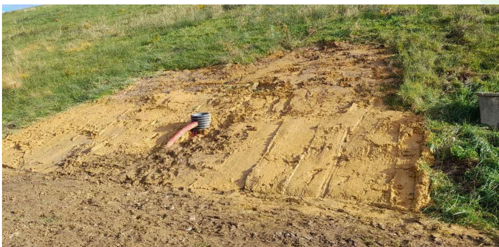
Figure 9 : Installation d'un regard pour le contrôle de la mouillère
