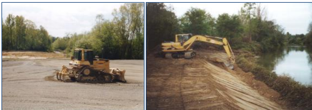
Figure 6 : La réhabilitation du site
