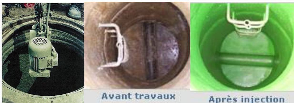
Figure n°34. Photos de la réhabilitation d'un regard par projection de résine
