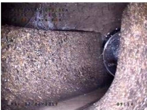
**Figure 10 Branchement trop pénétrant sur le tronçon R14-R15**
