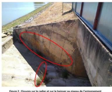
Figure 2 : Fissures sur le radier et sur le bajoyer au niveau de l'entonnement
